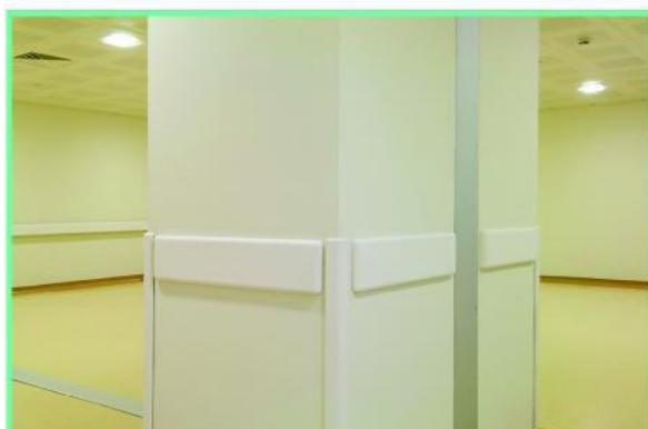
WG150 - отбойная доска шириной 150 мм., толщиной 20 мм.. Она монтируется на стену при помощи сплошного алюминиевого профиля с фиксирующими элементами с интервалом 50 - 60 см. и глушил удары при помощи резиновой прокладки. Алюминиевый профиль и дополнительные элементы (заглушки, переходники и т.д.) декорированы виниловым покрытием и могут быть одного цвета. Длина профиля 4 метра и производится в 12 цветах.
