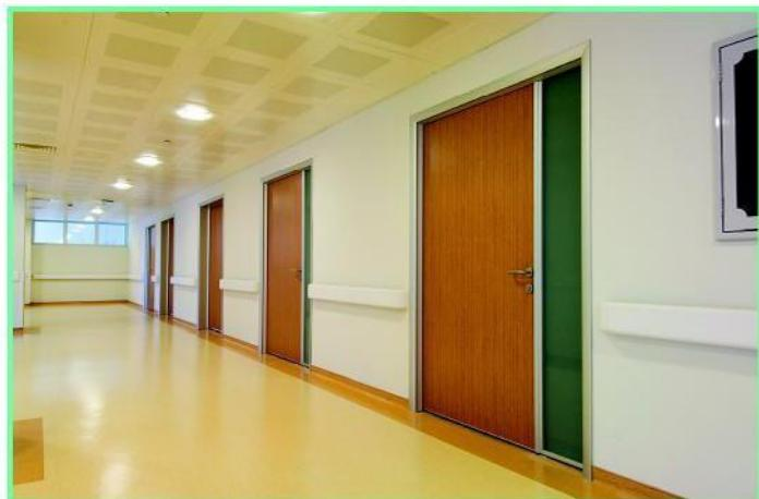
WG145 – поручень-отбойник шириной 145 мм, толщиной 85 мм, которая монтируется на стену сплошным алюминиевым профилем с разными фиксирующими элементами с интервалом 60-75 см. WG145 украшает и сохраняет интерьер здания. Декоративное виниловое покрытие в 12 разных цветах. Длина профиля - 4 метра.
